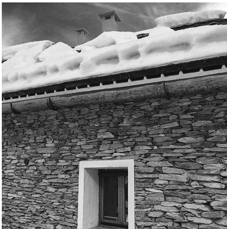
Foto n° 7: copertura di rifugio situato in zona alpina (2000 m slm) e realizzato con pannelli sandwich sui quali sono state posate listellature e scandole in legno.
