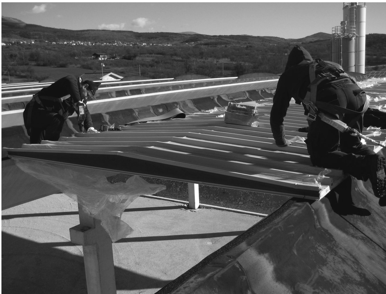
Foto n° 11: posa del pannello TECHTUM su travi alari in CAP
